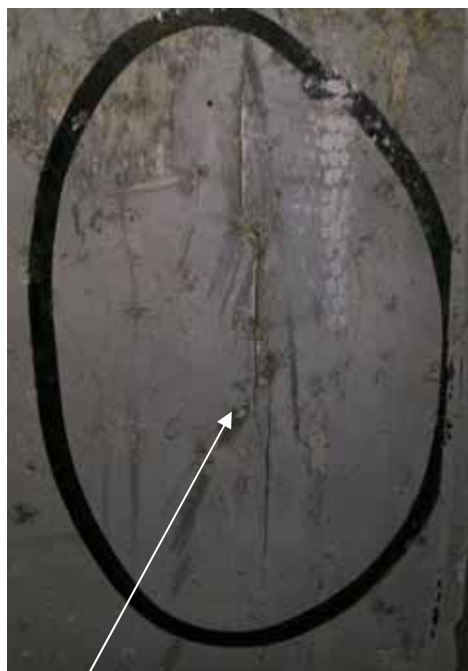
縦方向に発生した亀裂
